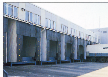
Решение с комбинацией перегрузочного моста и герметичного тамбура.
