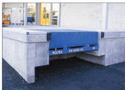
Перегрузочный мост в исходном положении.
